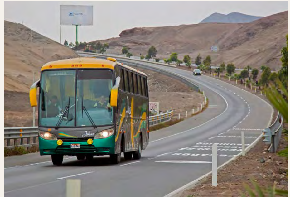
Figure 07: General photo of project. / Source: Rutas de Lima Figura 07: Foto del proyecto en general / Fuente: Rutas de Lima
