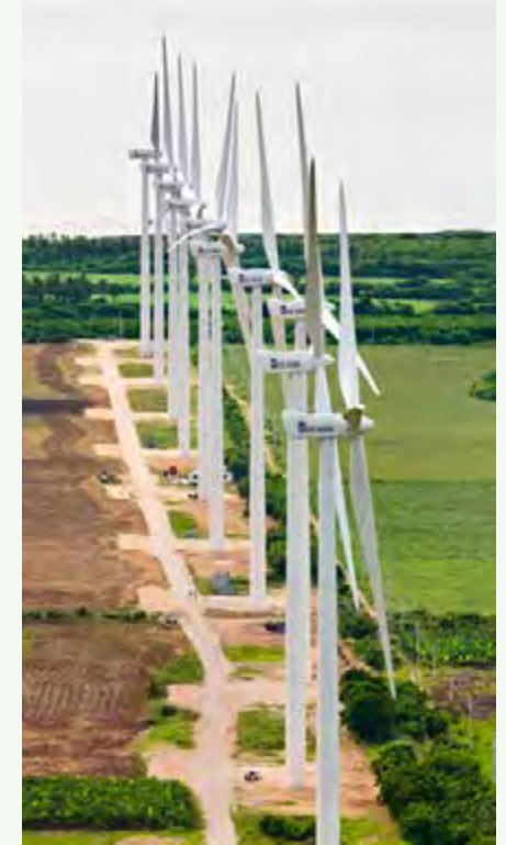
Figure 13: Row of wind turbines and access road / Source: EGE Haina. Figura 13: Fila de aerogeneradores y calles de acceso /Fuente: EGE Haina
