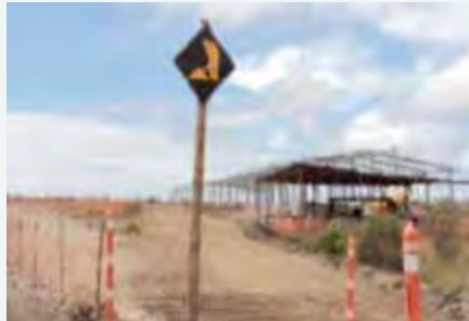
Figure 05: Signage on the construction site and construction area / Source: Pictures submitted by the project owner. Figura 05: Señalización en el área de construcción / Fuente: Fotos proporcionadas por el dueño del proyecto.
