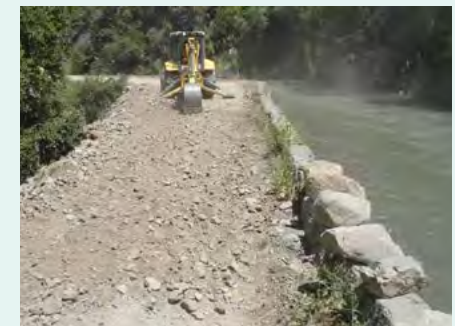
Figure 14: Improvement of canal edge / Source: Besalco S.A. Figura 14: Mejoramiento del borde del canal / Fuente: Besalco S.A.
