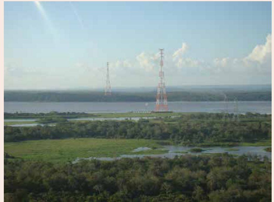
Figure 14: General view of the transmission towers and lines/ Source: ISOLUX CORSÁN Figura 14: Vista general de las torres y líneas de transmisión / Fuente: ISOLUX CORSÁN
