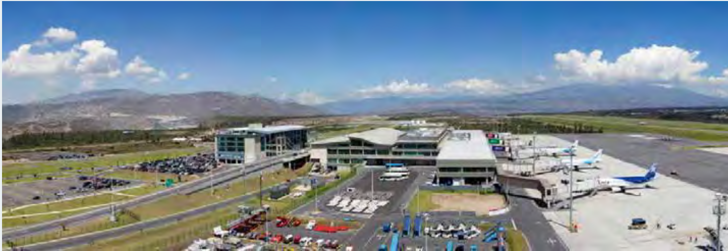
Figure 30: General picture of the project / Source: Corporación Quiport S.A. Figura 30: Foto general del proyecto / Fuente: Corporación Quiport S.A.
