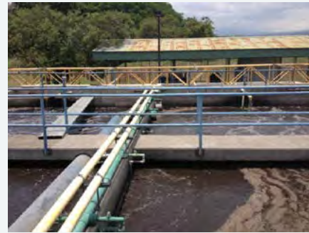
Figure 34: Wastewater treatment plant / Source: Picture taken during on-site visit, April 2013. Figura 34: Planta de tratamiento de Efluentes. / Fuente: Fotografía tomada durante la visita al sitio, Abril 2013.
