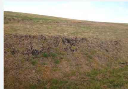
Figure 39: Measures to prevent landslides / Source: Picture taken during on-site visit, April 2013. Figura 39: Medidas para prevenir deslizamientos / Fuente: Fotografía tomada durante la visita al sitio, Abril 2013.
