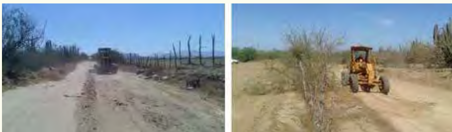
Figuras 04 and 05: Rehabilitation of two 2 km streets with access to Villas de la Paz / Source: Martifer Solar, Plan de Consulta y Relaciones Comunitarias: Proyecto Aura Solar I, 18.
