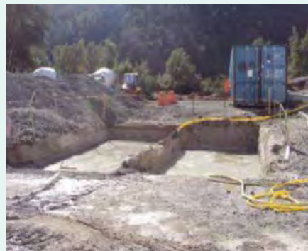
Figure 23: construction of concrete plant with a recirculating water system / Source: Besalco S.A. Figura 23: Construcción de una planta de concreto con sistema de recirculación del agua / Fuente: Besalco S.A.
