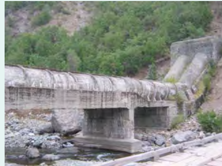
Figure 11: "El Melado Canal", siphon "El Toro", 1.2 km route / Source: Besalco S.A., US department of energy. Figura 11: Sifón "El Toro" en el canal "El Melado", ruta de 1.2 km / Fuente: Besalco S.A.; Departamento de Energía, Estados Unidos.
