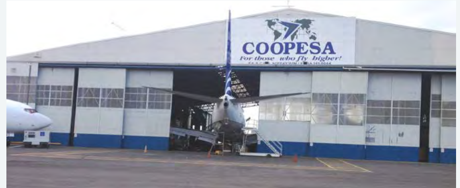
Figure 37: Overview of COOPESA installation / Source: Picture taken during on-site visit, April 2013. Figura 37: Vista de las Instalaciones de COOPESA / Fuente: Fotografía tomada durante la visita al sitio, Abril 2013.
