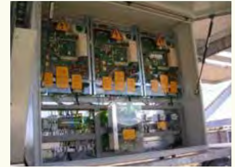
Figure 06: Electrical inverters at the plant / Source: SolarPack Figura 06: Inversores en las plantas solares / Fuente: SolarPack
