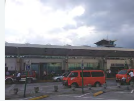
Figure 10: Main terminal entrance / Source: Picture taken during on-site visit, April 2013. Figura 10: Acceso principal a la Terminal / Fuente: Fotografía tomada durante la visita al sitio. Abril 2013.
