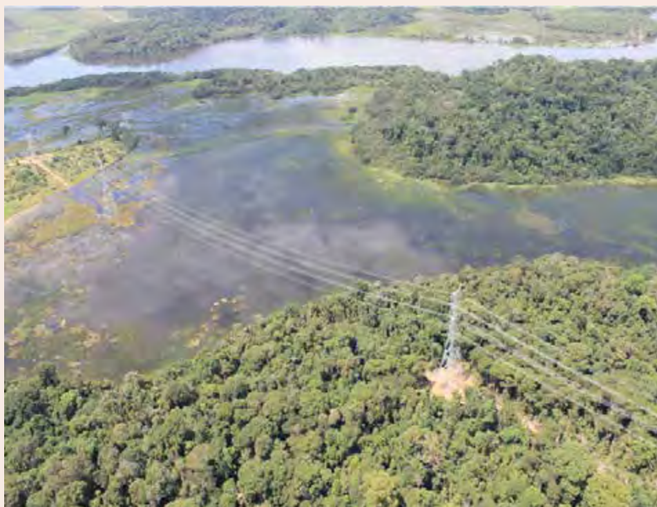
Figure 01: General view of the transmission lines / Source; ISOLUX CORSÁN Figura 01: Vista general de las líneas de transmisión / Fuente: ISOLUX CORSÁN
