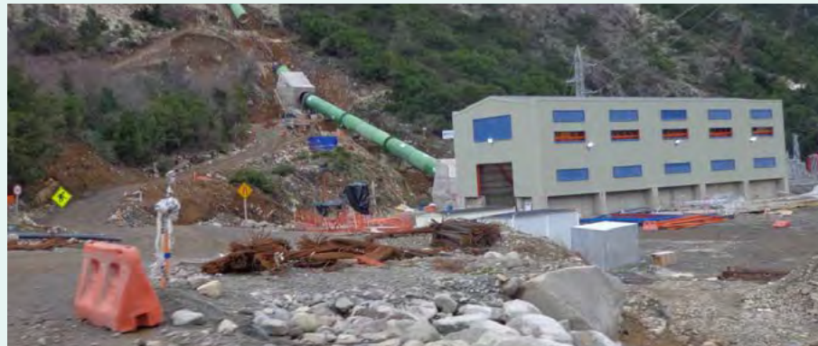
Figure 19: Signage in the works area / Source: Besalco S.A. Figura 19: Señalización en la zona de obras / Fuente: Besalco S.A.
