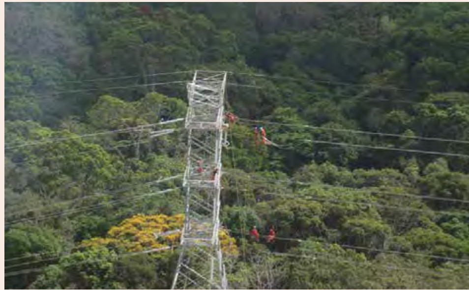
Figure 16: General view of a transmission tower/ Source: ISOLUX CORSÁN Figura 16: Vista general de una torres de transmisión / Fuente: ISOLUX CORSÁN
