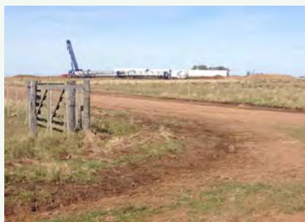
Figure 14: Improvements of the paths within the wind farm / Source: Picture taken during on-site visit, May 2013. Figura 14: Mejoras en los caminos dentro del Parque Eólico / Fuente: Fotografía tomada durante la visita al sitio en Mayo 2013
