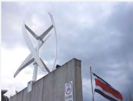
Figure 22: Eolic Generator provides electricity to the parking / Source: Picture taken during onsite visit, April 2013 Figura 22: Generador eólico proporciona energía al estacionamiento / Fuente: Fotografía tomada durante la visita al Sitio. Abril 2013.
