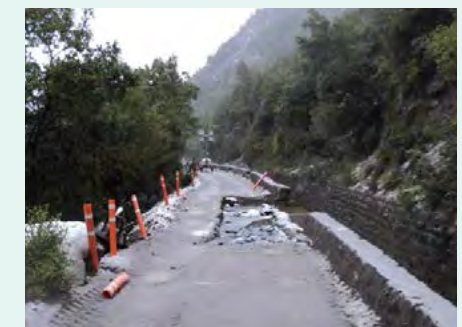
Figure 04: Improvement of canal edge. Picture provided by Besalco S.A. Figura 04: Mejoramiento del borde del canal Fotografía proporcionada por Besalco S.A.
