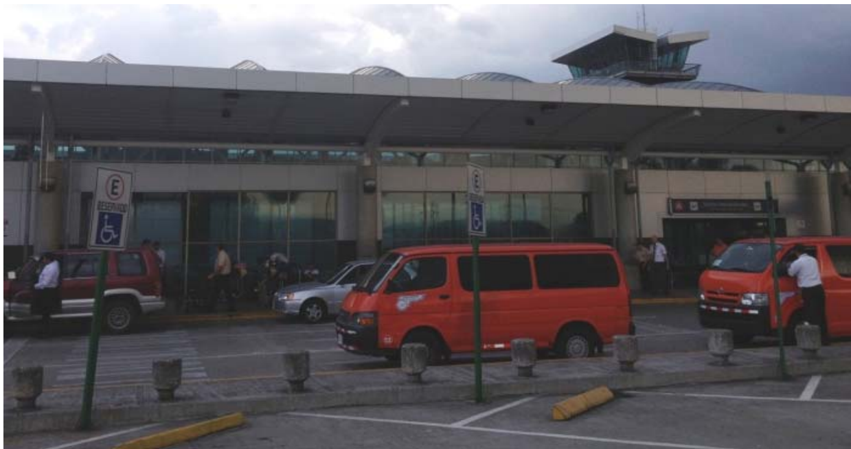
Figura 12: Acceso principal a la Terminal. Fuente: Fotografía tomada durante la visita al sitio. Abril 2013.
