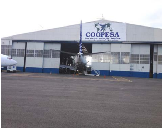
Figura 15: hangar de COOPESA.
