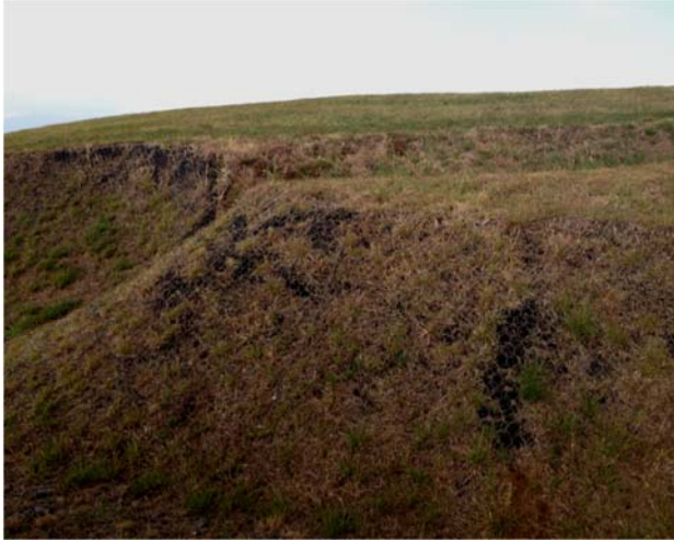
Figura 13: Prevención de erosión en los taludes.
