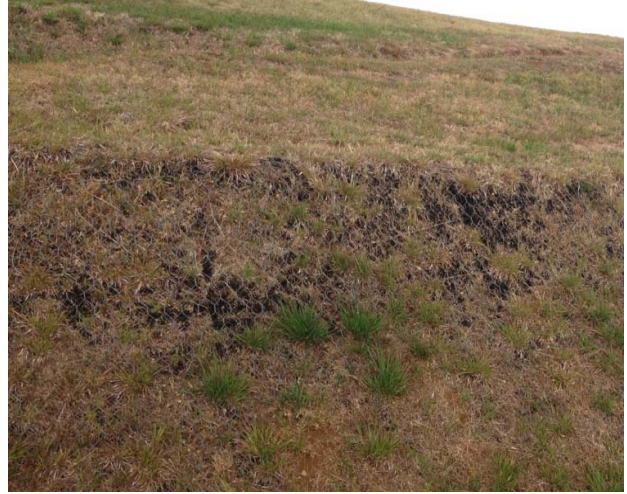
Figura 14: Prevención de erosión en los taludes.
