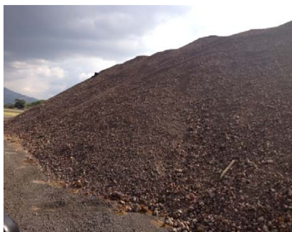
Figura 24: Reúso del material excavado. Fuente: Fotografía tomada durante la visita al sitio. Abril 2012
