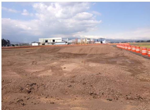
Figura 23: Reúso del material excavado. Fuente: Fotografía tomada durante la visita al sitio. Abril 2012
