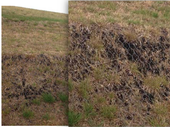
Figura 55: Medidas para prevenir deslizamientos. Fuente: Fotografía tomada durante la visita al sitio, Abril 2013
