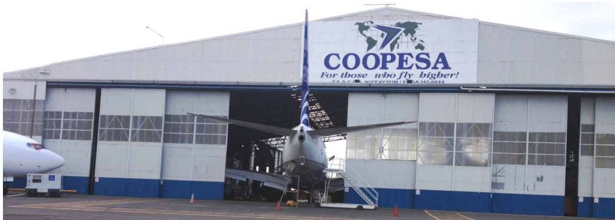
Figura 53: Vista de las Instalaciones de COOPESA / Fuente: Fotografía tomada durante la visita al sitio, Abril 2013.
