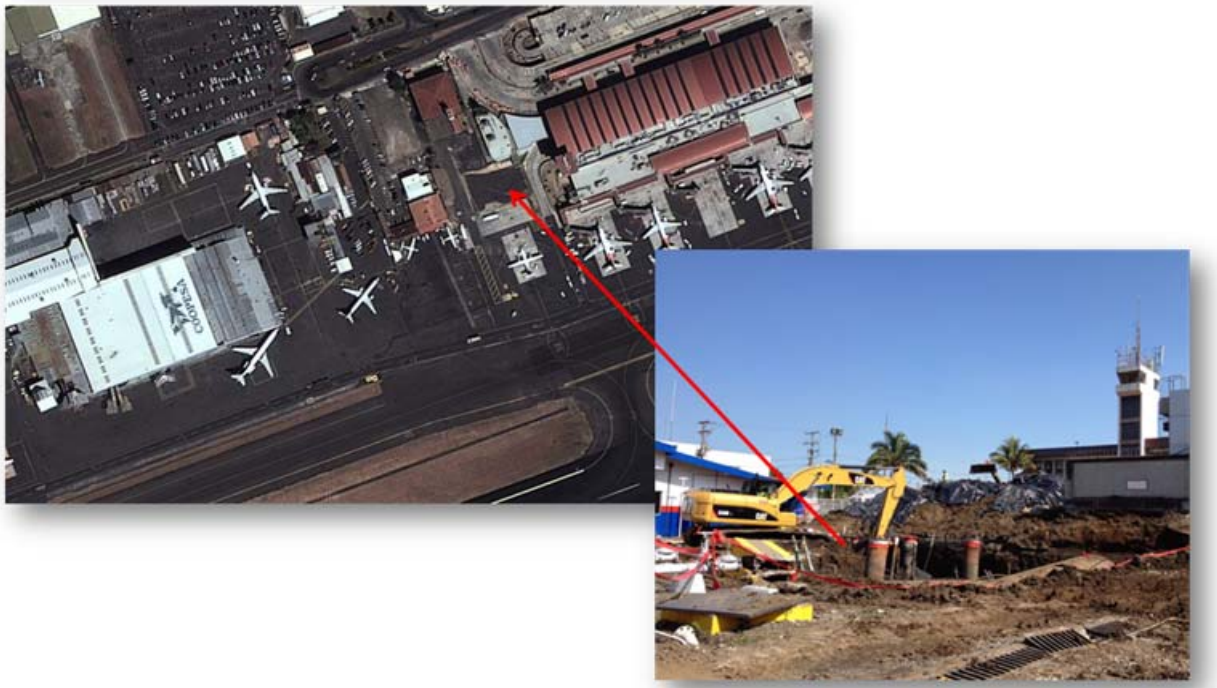
Figura 54: Proceso de limpieza del suelo. Fuente: Fotografía proveída por AERIS
