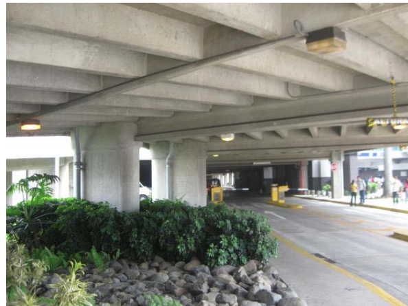
Figura 34: Reemplazo de las luces del estacionamiento con lámparas LED.
