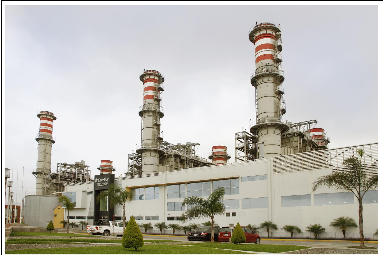
Figura 01: Vista general del proyecto. Fuente: EnerSur.
