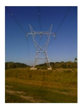
Figure 25: Free Standing Structure Source: IDB. Informe de Supervisión Ambiental: Transmisión Eléctrica para el Norte Grande. (Argentina: 06 April 2011), 10.
