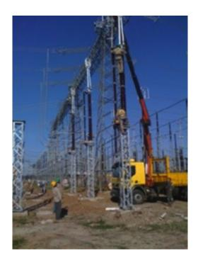
Figure 24: On-site assembly of transmission station Source: IDB. Informe de Supervisión Ambiental: Transmisión Eléctrica para el Norte Grande. (Argentina: 06 April 2011), 10.
